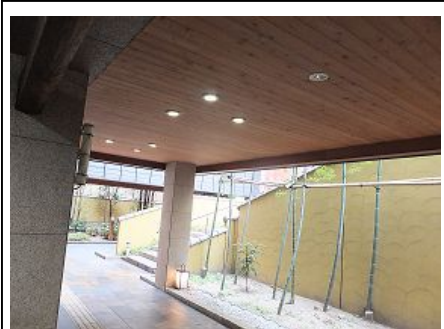
外部廊下 LED ダウンライト
