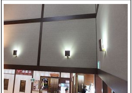
階段壁面 LED 電球取替
