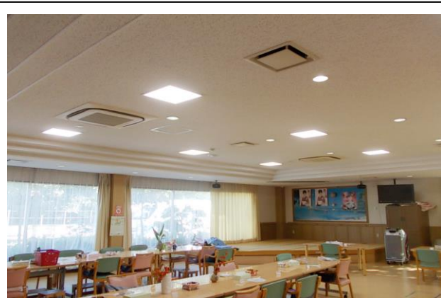
デイルーム 施工後
