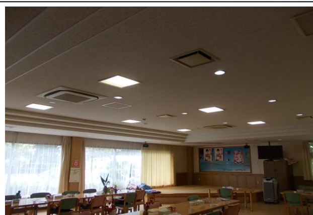
デイルーム 施工前
