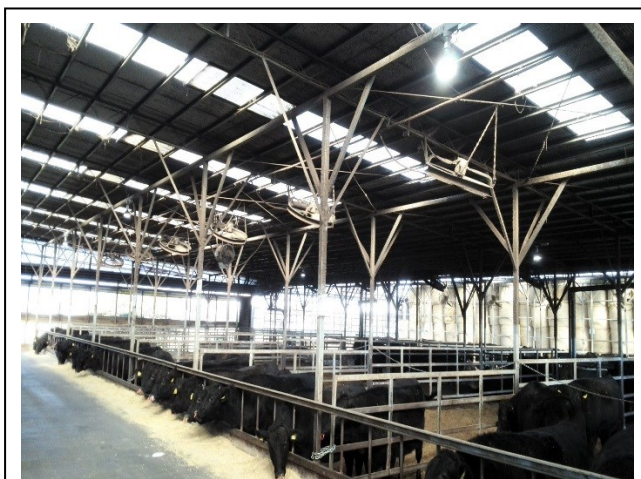
牛舎天井への LED 照明導入
